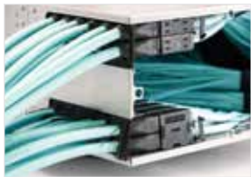
顶部和底部光缆固定
