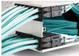
顶部和底部光缆固定
