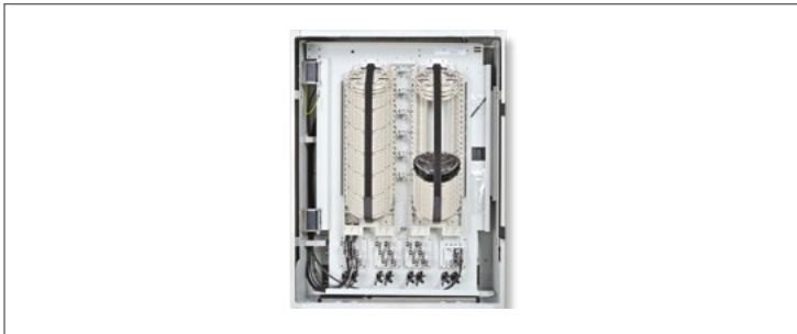
Gf-NVT im KVZ82, Spleißbereich
